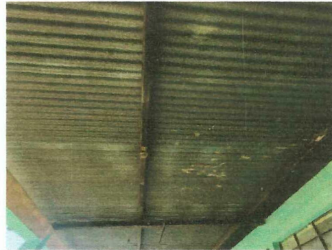
Foto 2: Vista panorámica estado actual de cubierta de lamina de escuela.
