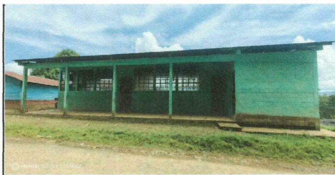
Foto 5: Vista frontal de corredor de establecimiento
